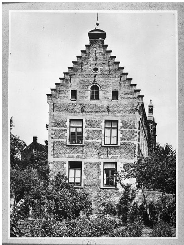
Aanwezige jaarankers '1685' in de zuidelijke kopgevel.
